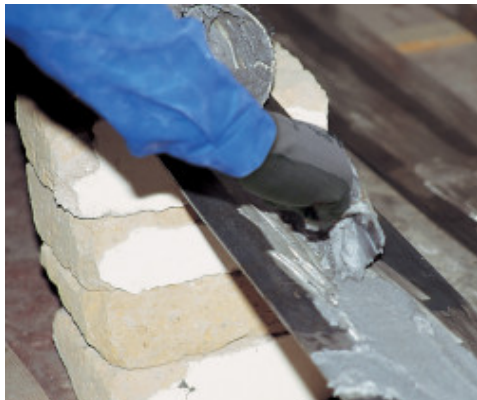
Påføring av Adesilex PG1 på metallplate
