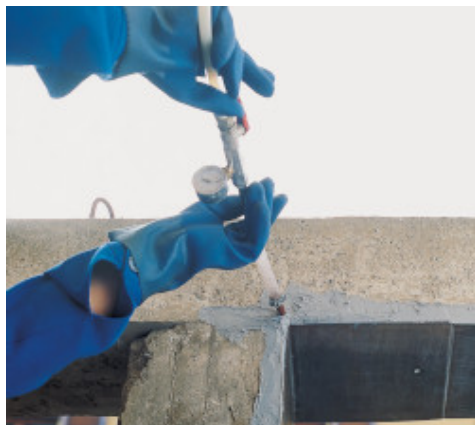
Søyle påført med Adesilex PG1
