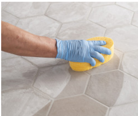
Rengjøring og sluttbehandling av fuger med en hard cellulosesvamp
