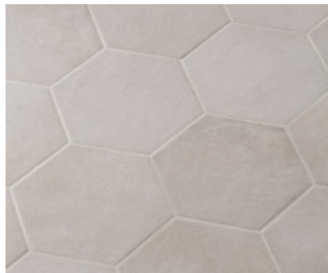
Gulv fuget med Keracolor FF
