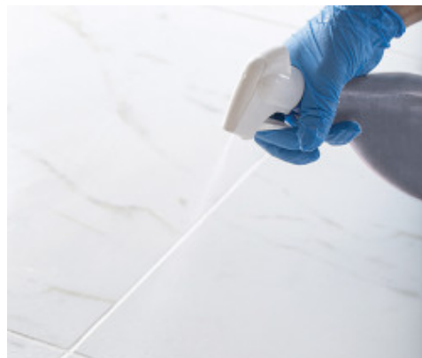
Mulig sluttrengjøring med UltraCare Kerapoxy Cleaner
