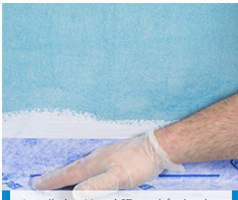
Installering Mapei ST tettebånd ved hjelp av Mapegum WPS, overgang gulv/vegg
