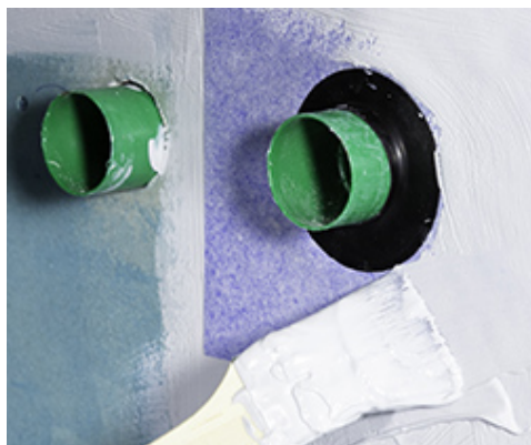
Mapeguard PC 32 - 55 cm rørmansjett montert i Mapegum WPS
