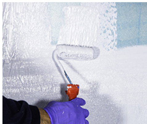
Påføring av Mapegum WPS membran med eksempelvis rulle
