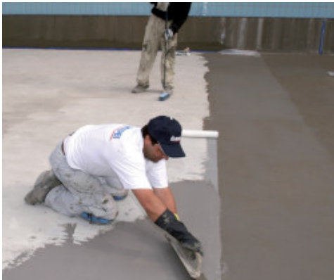
Vanntetting av svømmebasseng med Mapelastic Zero
