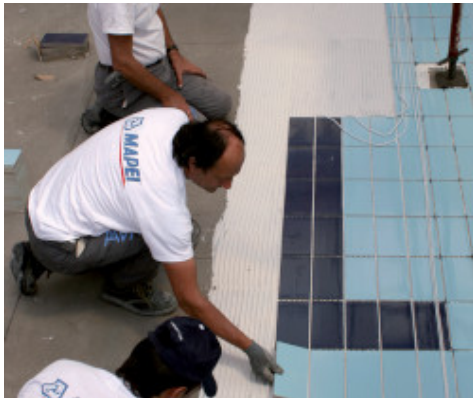
Legging av keramisk flis på Mapelastic Zero i svømmebasseng
