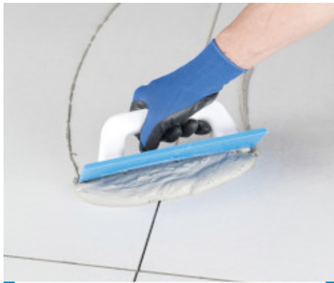
Fuging av Porselenato fliser med Ultracolor Plus
