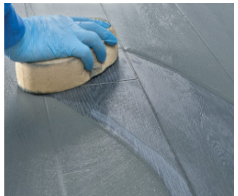
Vasking av fuger med hard svamp (spongo)
